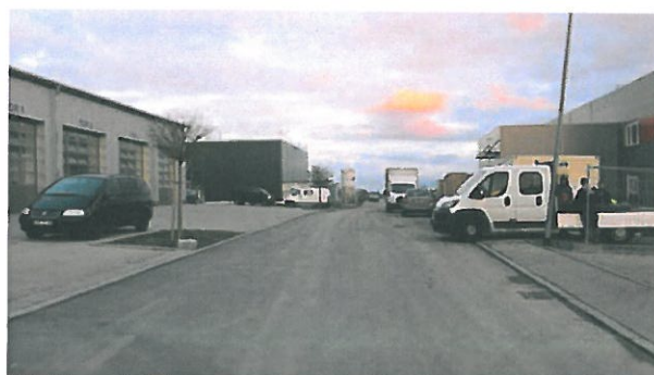
Abbildung 7: Zufahrtsstraße mit Wendehammer am Ende der Straße
