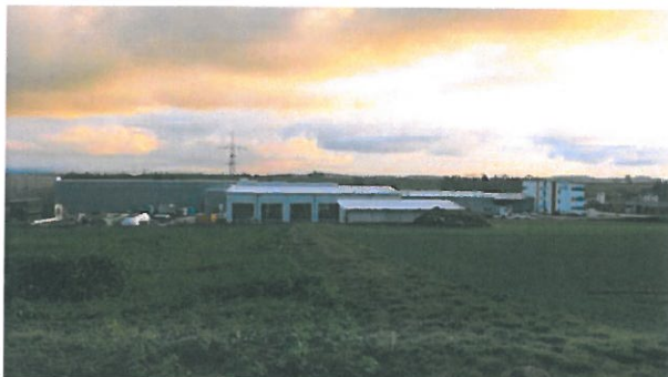
Abbildung 6: Bestandsgebäude im nordwestlichen Plangebiet
